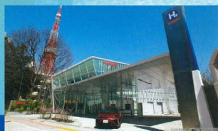
■ 水素ステーション
