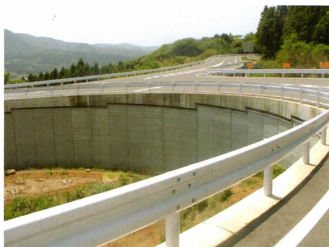
地滑り地盤頭部への盛土は、地滑りの誘発要因となります。増加荷重となる盛土荷重を軽量なEDO-EPSブロックを併用して置き換えることで、現地盤への荷重増加を抑え、地滑りの誘発対策を行うことができます。
