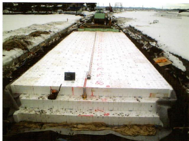
軟弱地盤上の盛土は地盤沈下の要因となります。増加荷重となる交通荷重と盛土荷重を軽量なEDO-EPSブロックを併用して置き換えることで、現地盤への荷重増加を抑え、沈下防止に効果があります。
